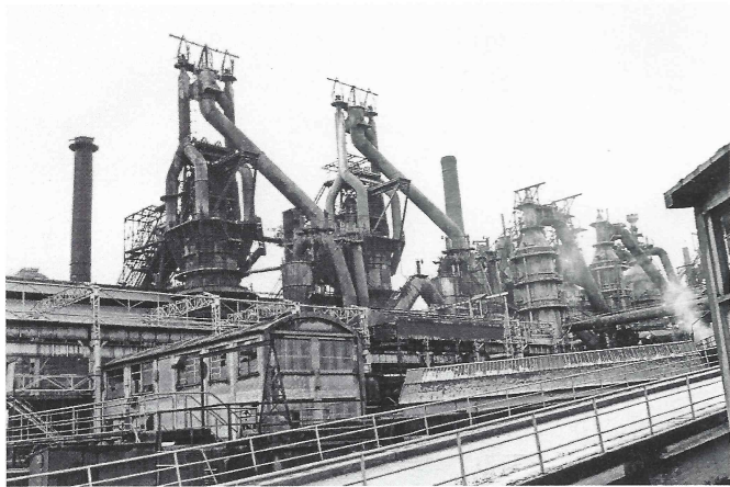
Senelle (Longwy). Les hauts-fourneaux.
