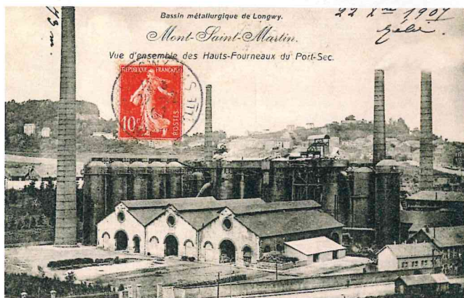
Mont-Saint-Martin. Vue d'ensemble des hauts fourneaux du Port-Sec.
