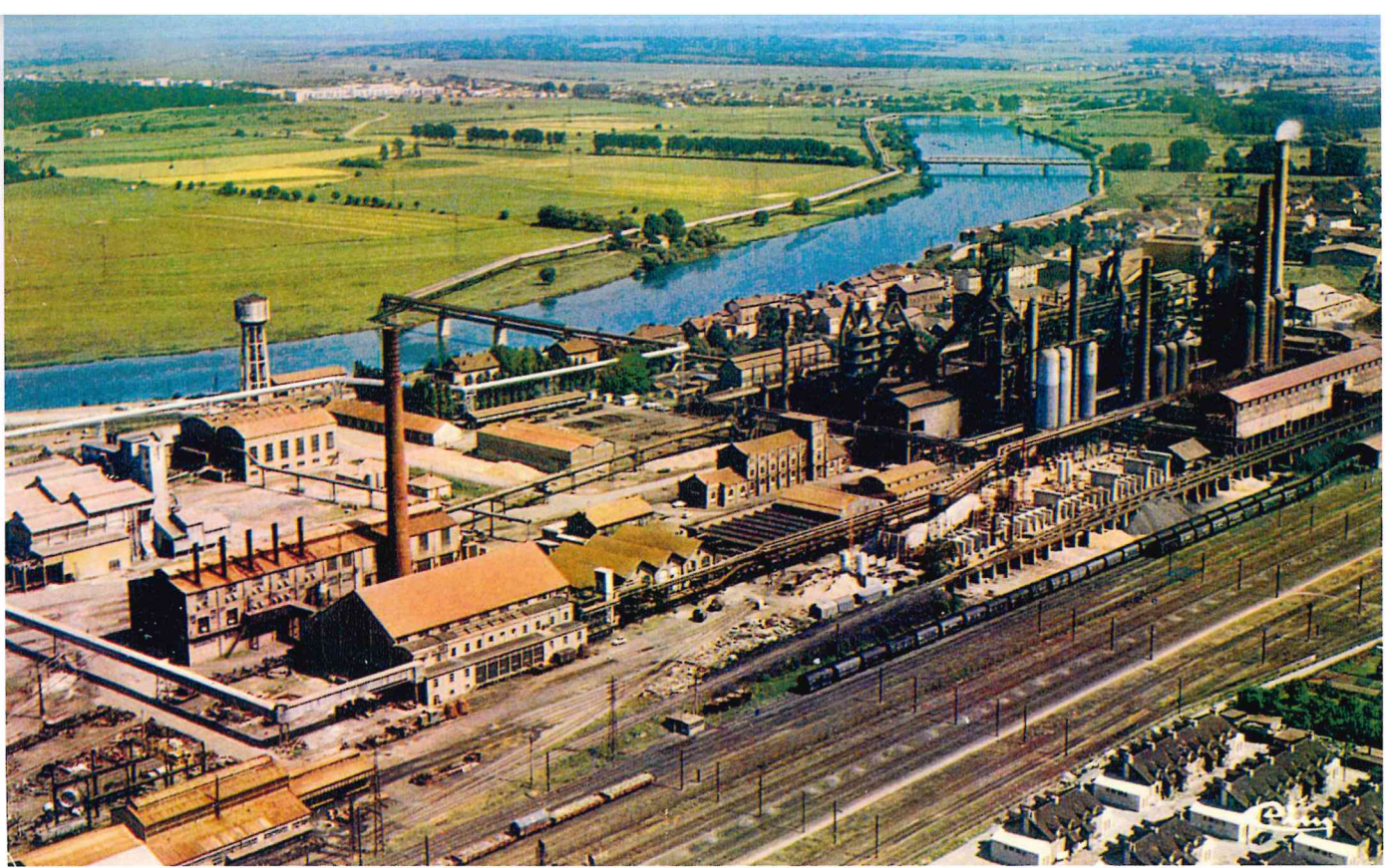
Uckange. Vue aérienne de l'usine.
